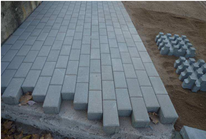
Formación carril bici segregado en fase 2
