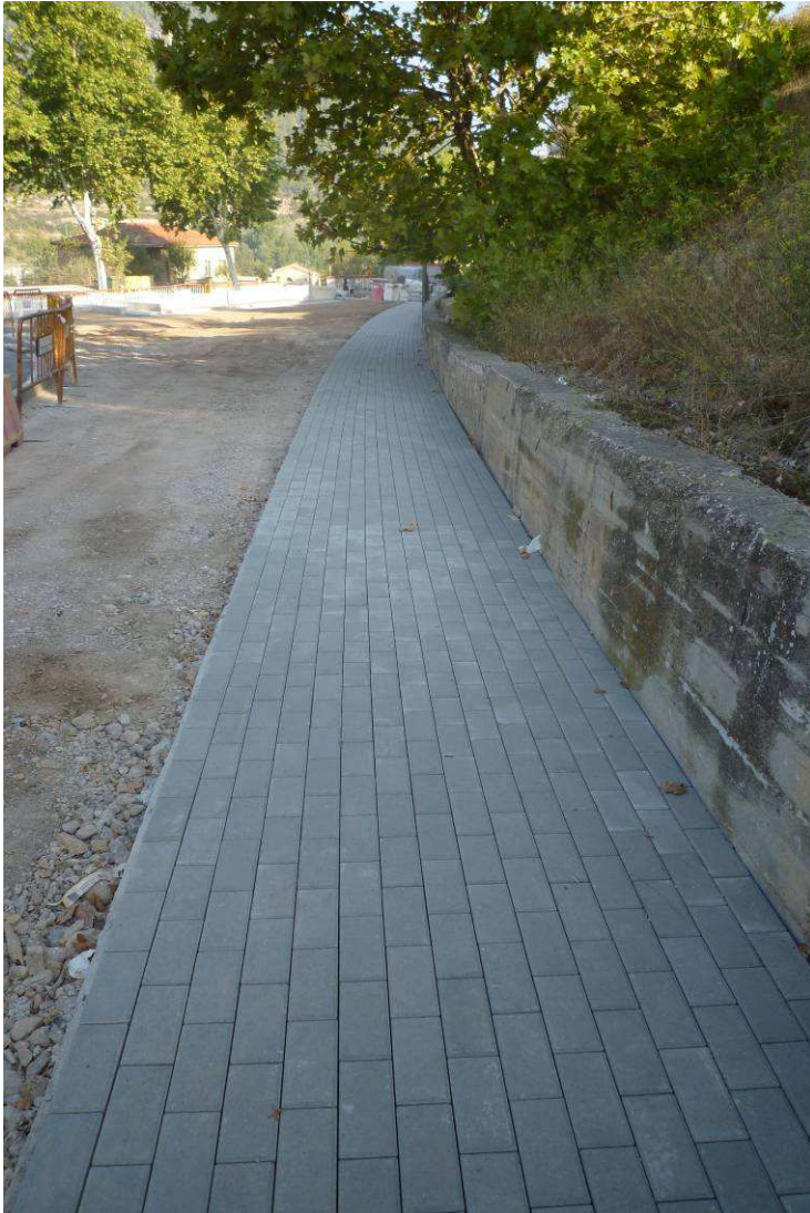
Formación carril bici segregado en fase 2
