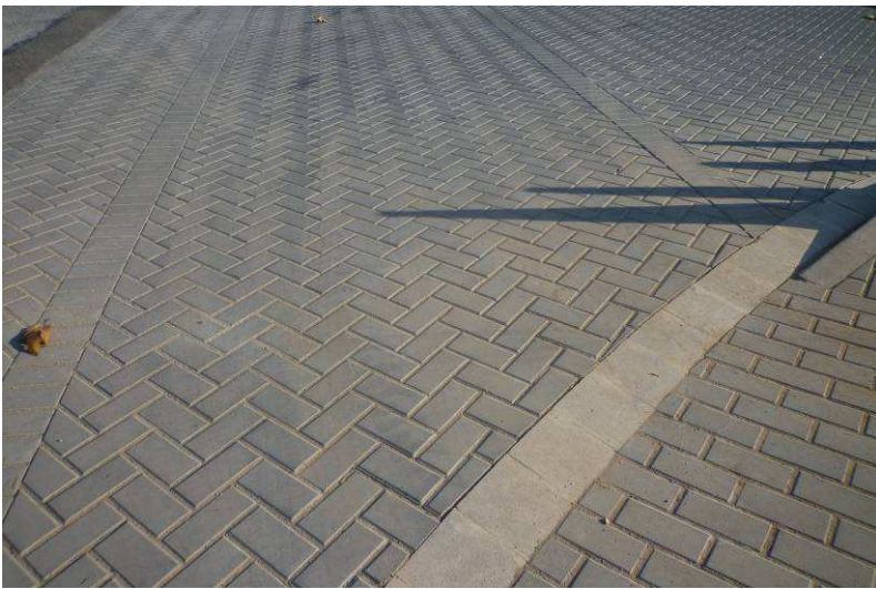
Paso peatonal fase 2
